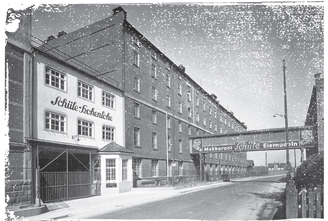
Die Schüle-Fabrik unweit des Bahnhofs prägt seit über einem Jahrhundert das Ortsbild von Plüderhausen. Inzwischen wird dort Arbeitskleidung für das Bekleidungswerk Paul H. Kübler geschneidert. Foto: Paul H. Kübler
